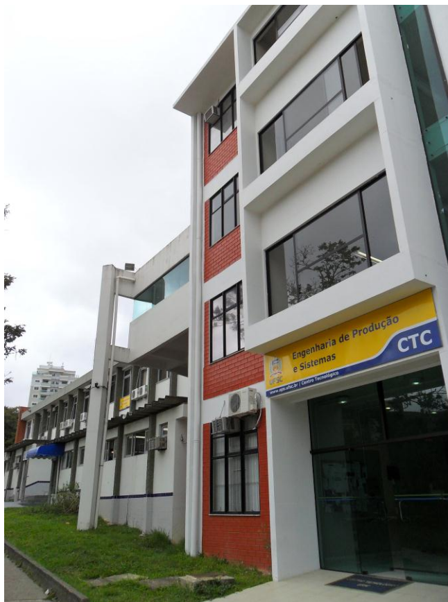
Figura 4.8.1 - Prédio do Departamento de Engenharia de Produção e Sistemas.
