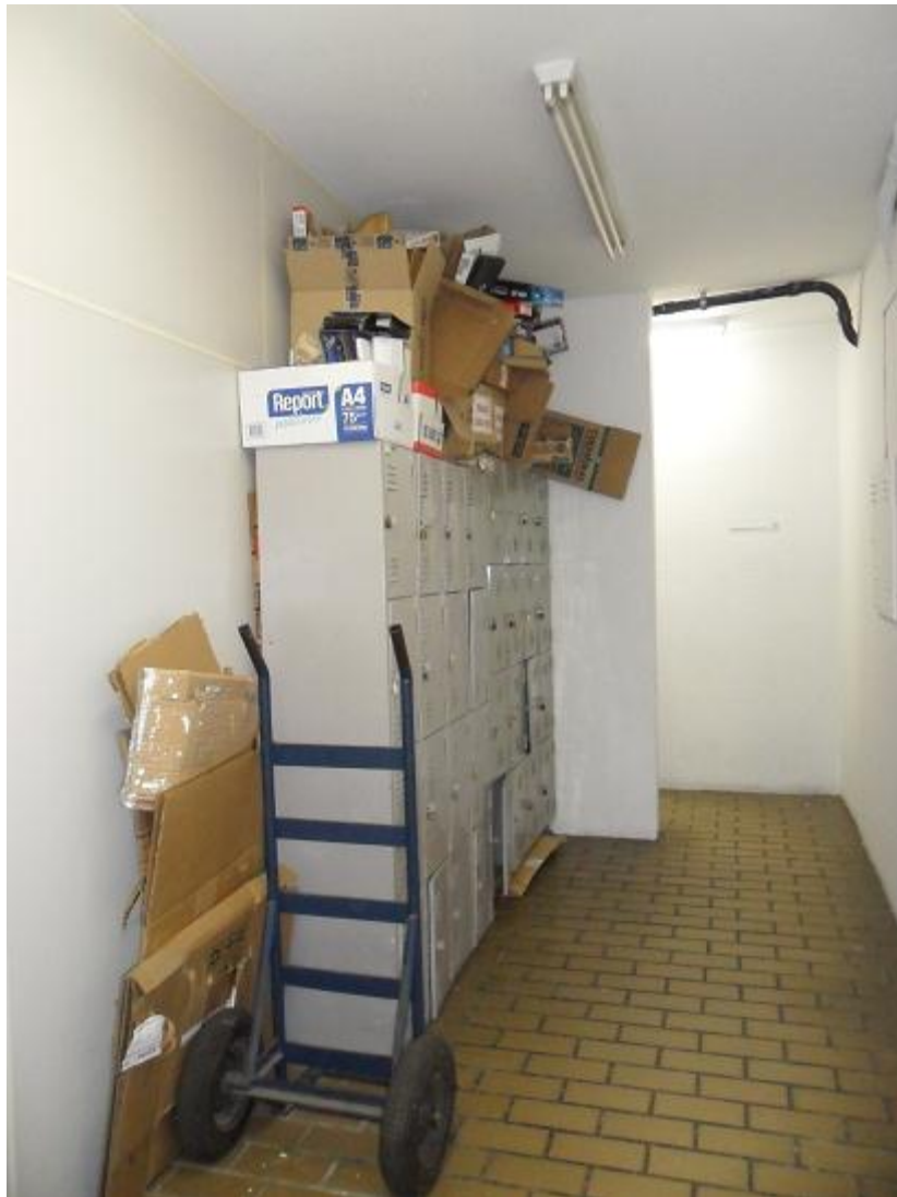
Figura 4.7.4 - Acúmulo de papelão no corredor do prédio.
