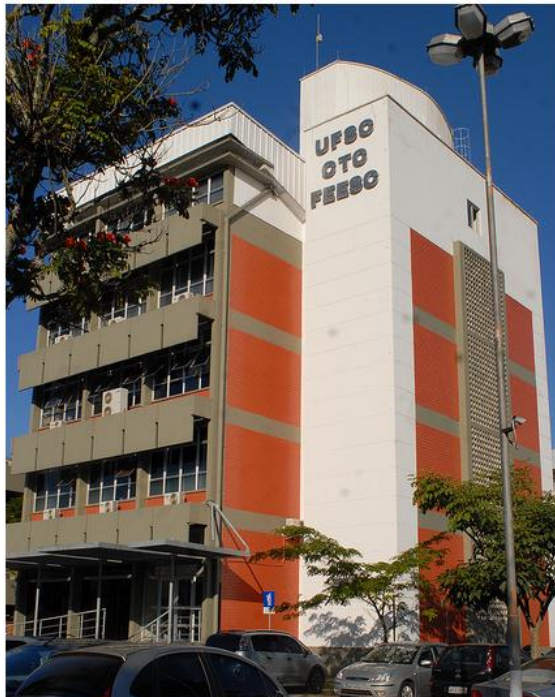
Figura 4.2.1 - Prédio da FEESC
