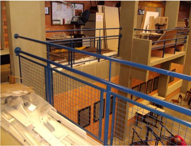
Figura 4.3.19 - Acúmulo de matérias - Corredor do primeiro andar
